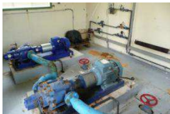
Fig. 2-e : Pompes de refoulement vers le réservoir
